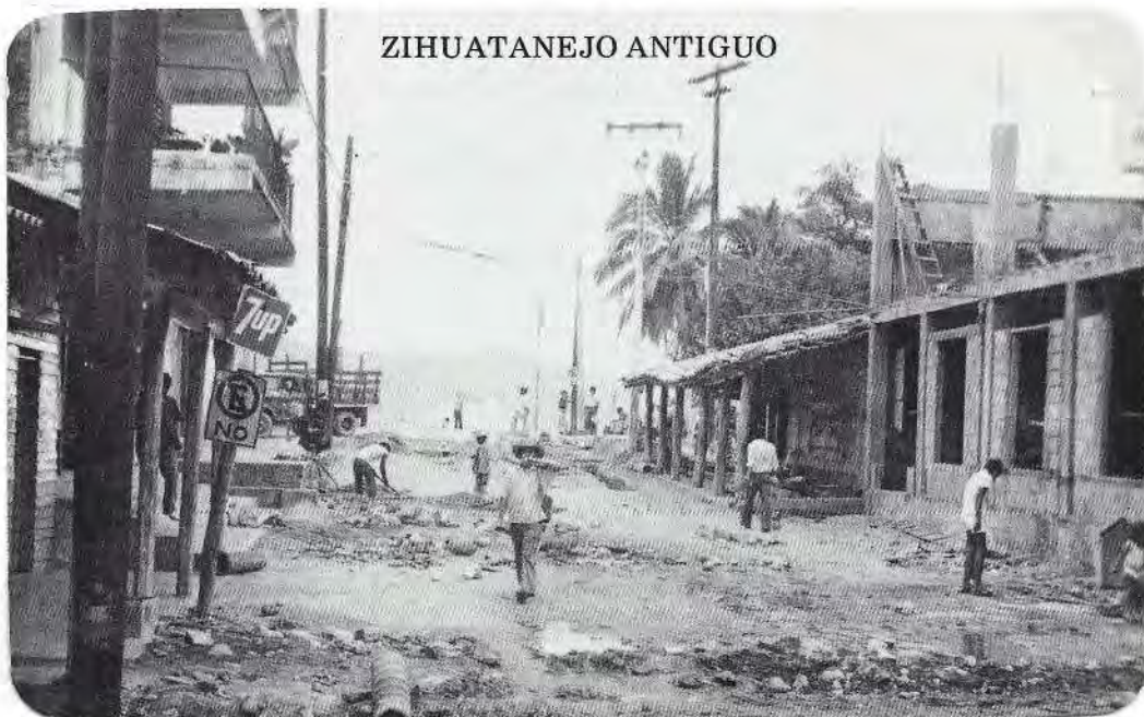
Calle Cuauthémoc labores de urbanización (agua y drenaje) c.1965
